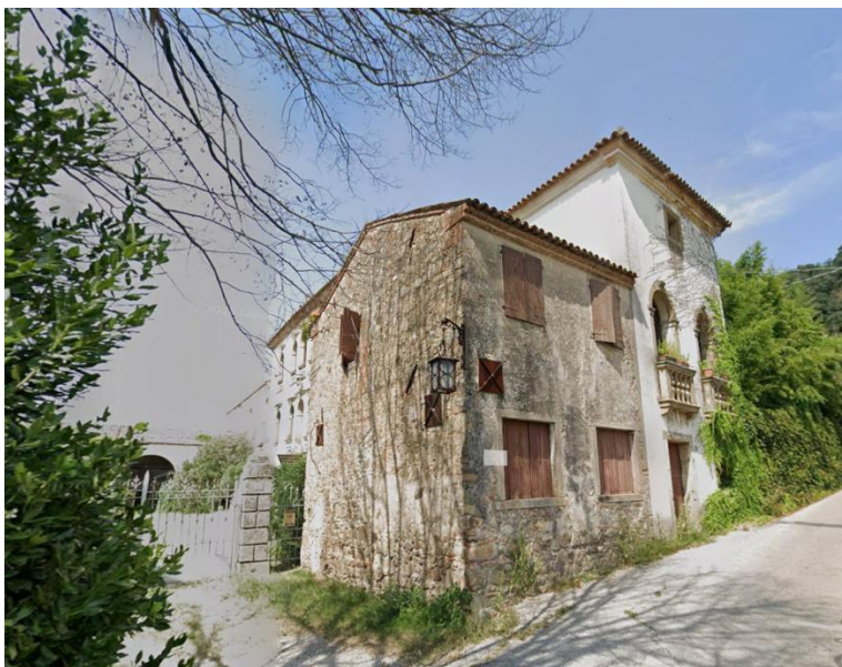
Ingresso lato est
