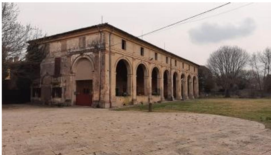
FOTO PROSPETTO NORD
