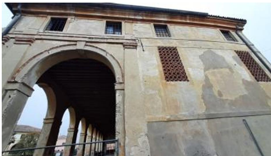
FOTO PROSPETTO SUD
