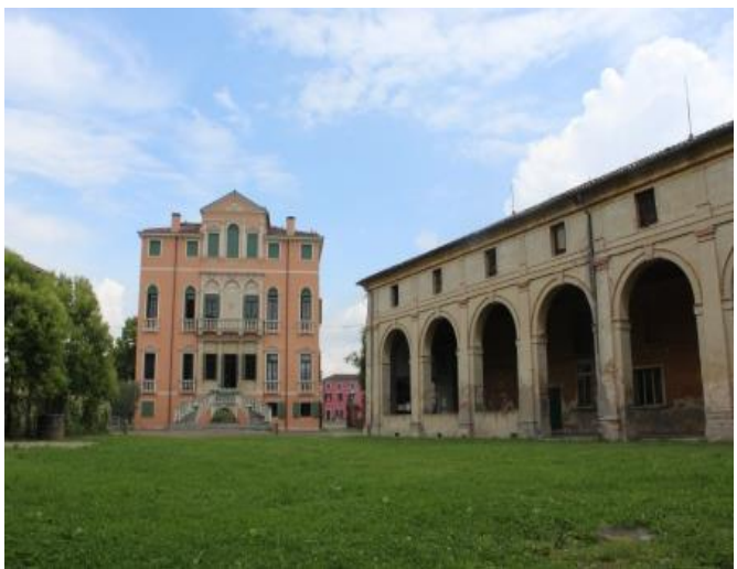
Parte interna con parte di barchessa
