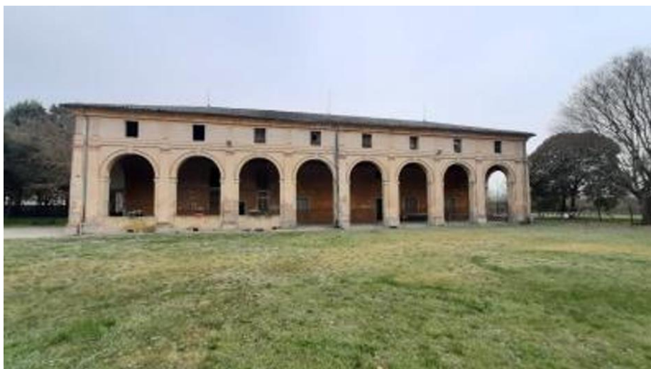
FOTO PROSPETTO OVEST
